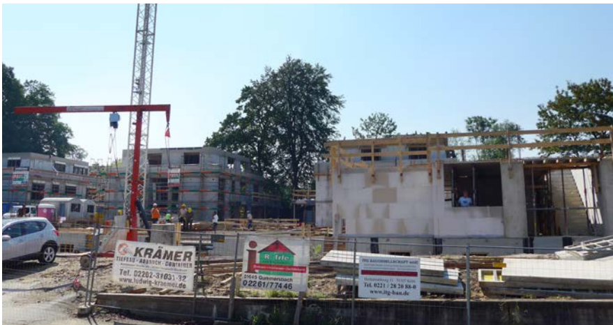
Neues „Wohnen an der Flora“: Hier entstehen 31 Eigentumswohnung.
