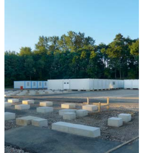
Im Aufbau: Containersiedlung in Lückerath.
