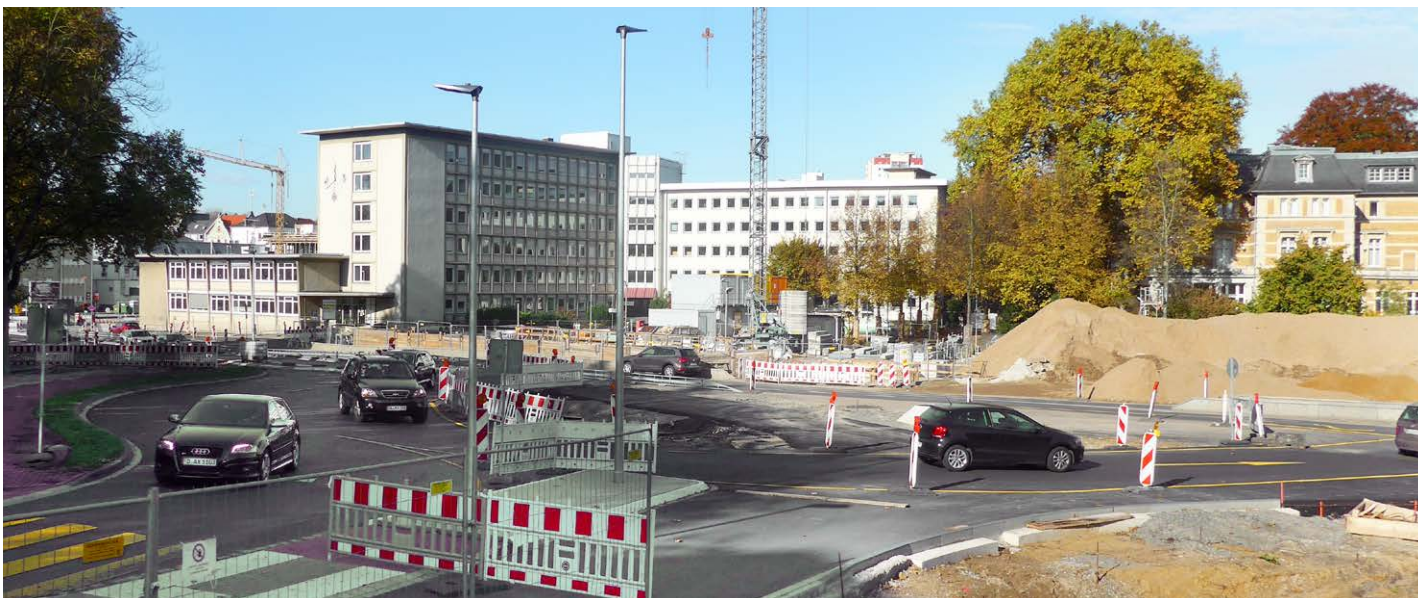
Der neue Kreisverkehr „Schnabelsmühle“ in der Innenstadt gewinnt an Konturen. Aber: Das Großprojekt hat sich verteuert.
