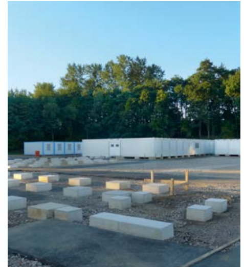
Im Aufbau: Containersiedlung in Lückerath.
