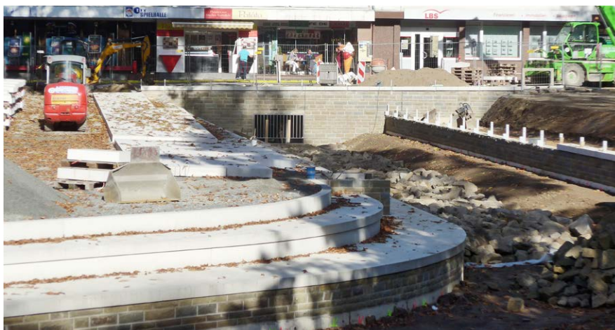
An dieser Stelle wird bald die Strunde durch den Forumspark fließen.
