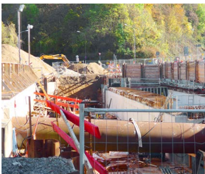
Gewaltige Erdarbeiten beim alten Stadthaus.
